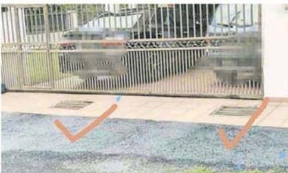
■根据标准，每10尺的距离就必须有沟渠洞口。
