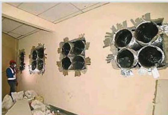
8号单位被做为“排气室”，有降温的“散热管”设置，把挖矿机散发的热气，通过抽风管抽送到室外。
