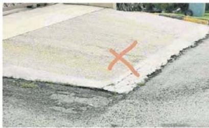
■沟渠洞口若全面以洋灰封盖，底下沟渠阻塞也毫不知情，同时也影响当地排水系统。
